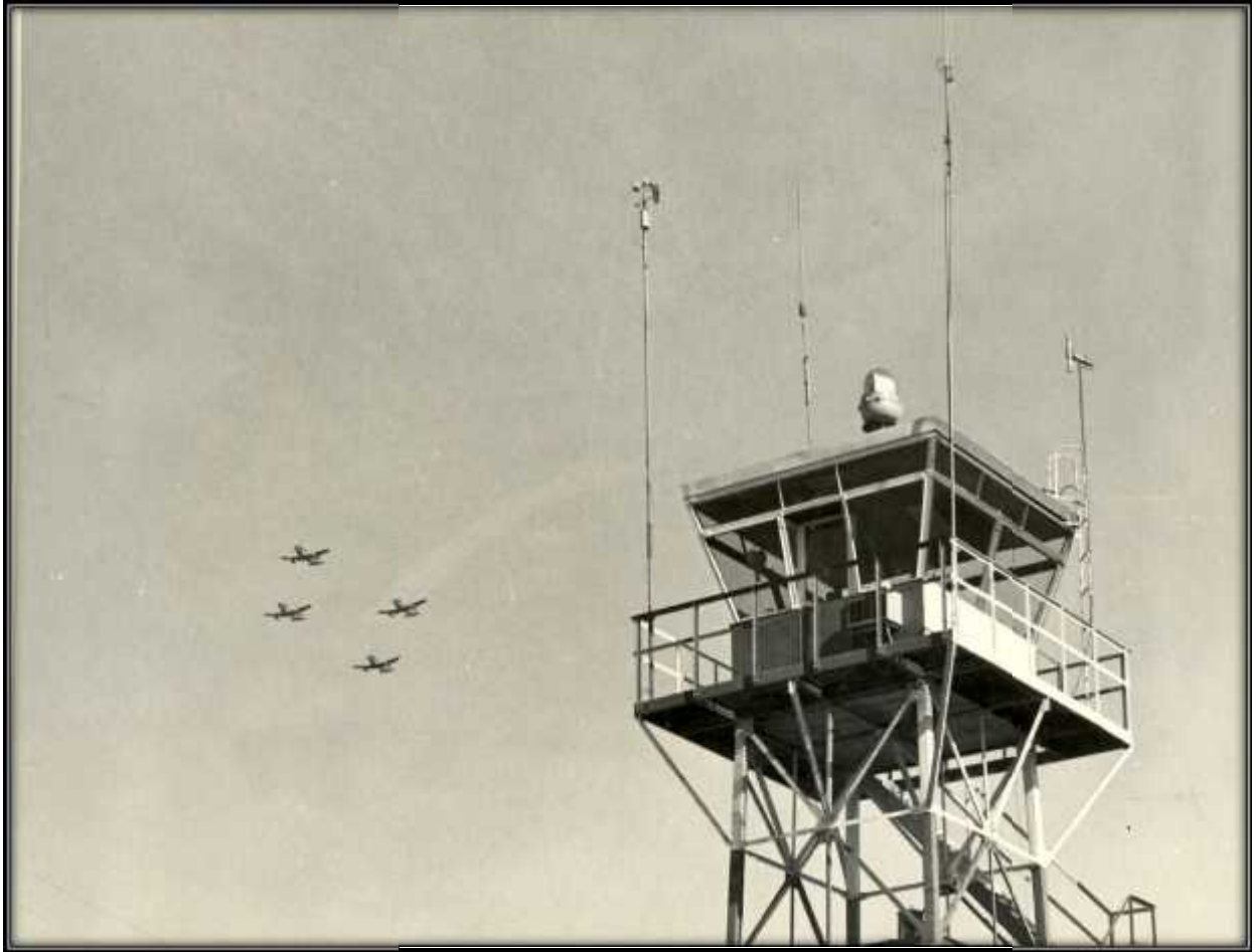
Segunda pasada sobre la torre de control de El Belloto.
