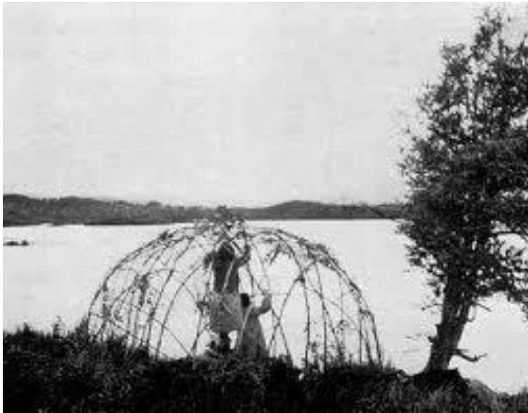
Construcción de una habitación típica kawésqar
